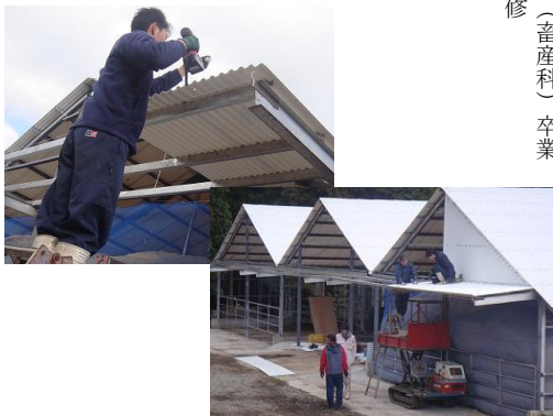
牛舎建設の様子
