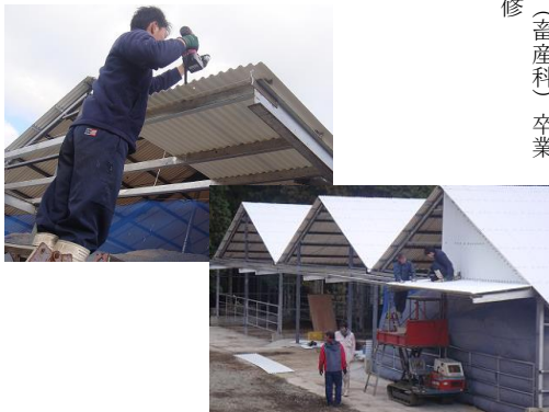
牛舎建設の様子
