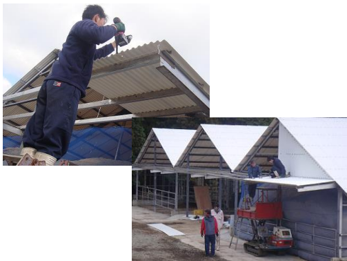
牛舎建設の様子
