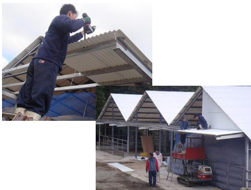
牛舎建設の様子
